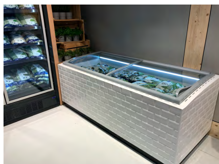
Marktinstallation. Wandmontage mit maßgeschneiderter Verkleidung.
